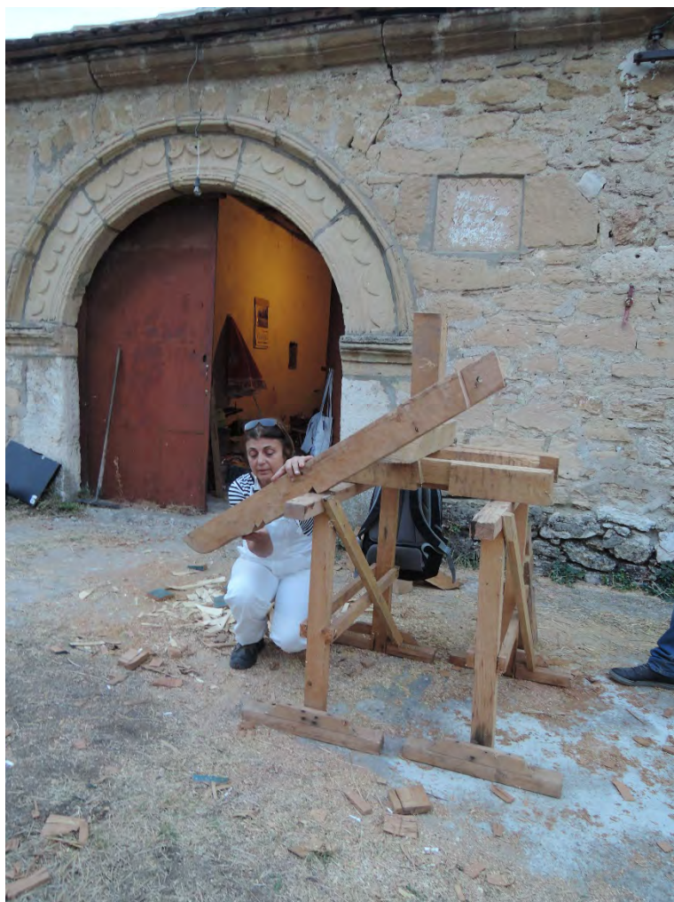
Предавање и демонстрација спојева традиционалних дрвених конструкција зидова и кровова у пивницама (Босиљка Томашевић)
