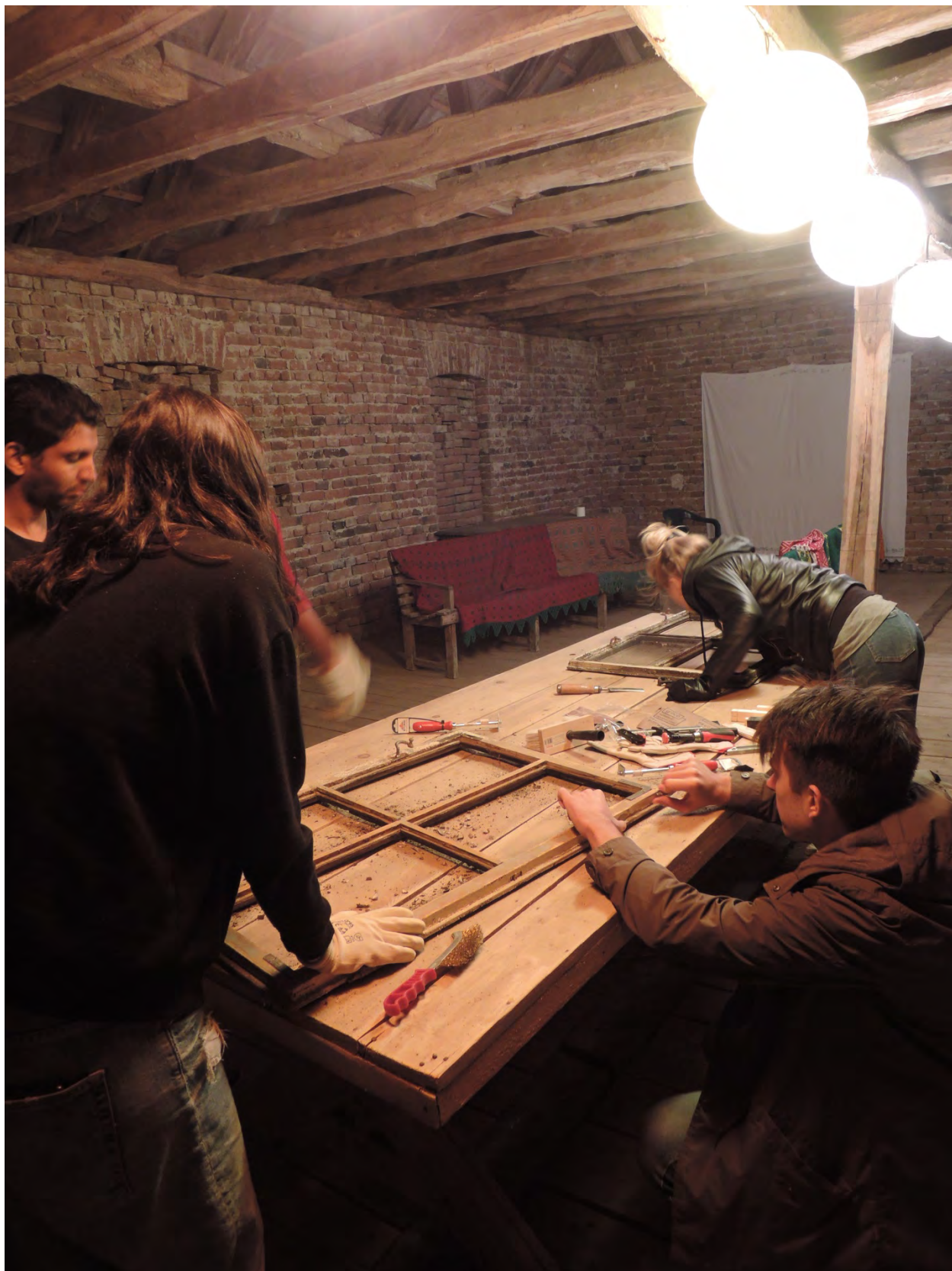
Чишћење и рестаурација прозора са куће Вучка Рајића
