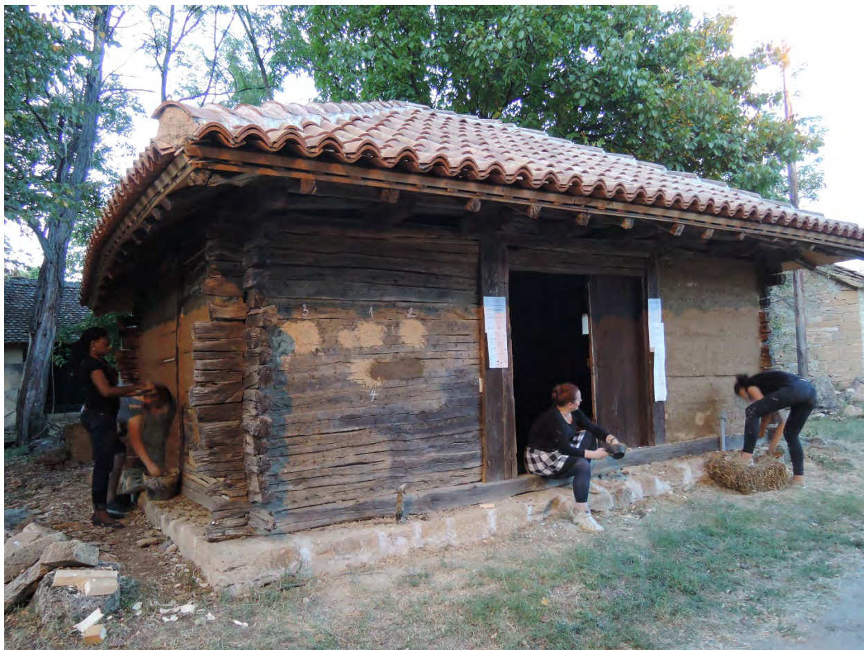
Наношење првог слоја малтера и тестови другог слоја
