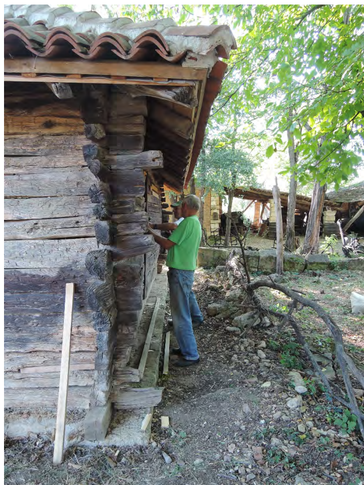
Припрема зидова за наношење првог слоја малтера
