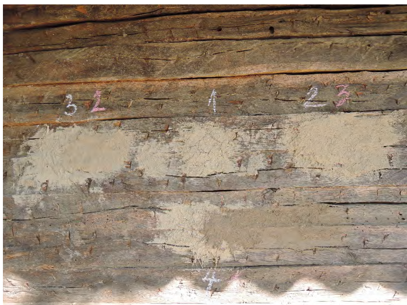
Наношење првог слоја малтера и тестови другог слоја
