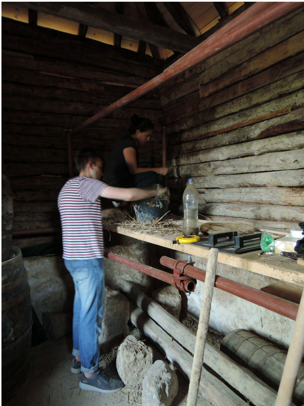
Почетак радова на унутрашњем зиду (један слој малтера)
