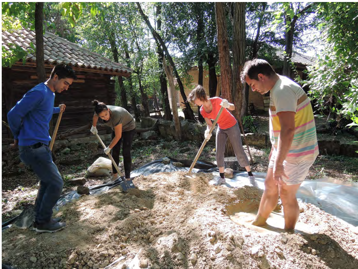
Припрема блата за малтер: након што је земља уситњена, натапа се водом и остаје да преноћи
