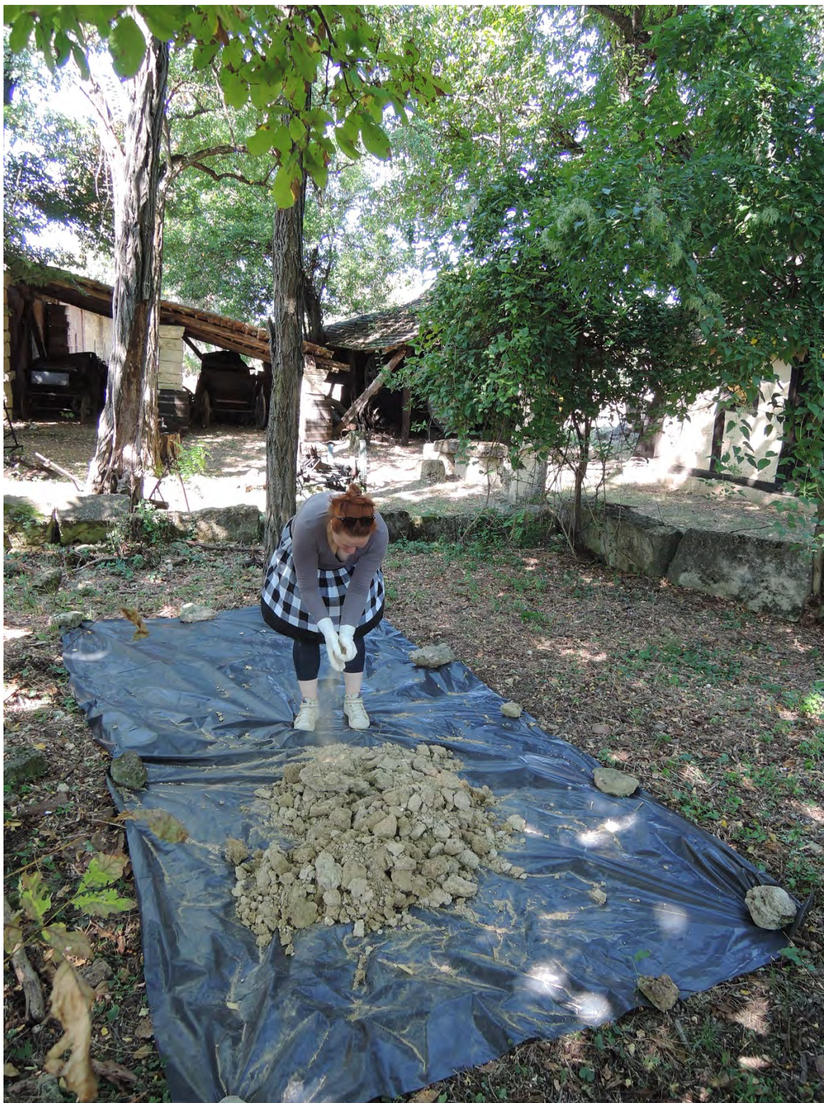
Припрема земље за први слој блатног матера: уситњавање рециклираног малтера и чишћење од камења
