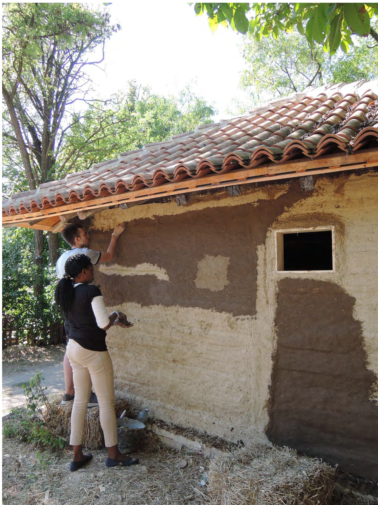
Наношење другог слоја малтера по сушењу првог
