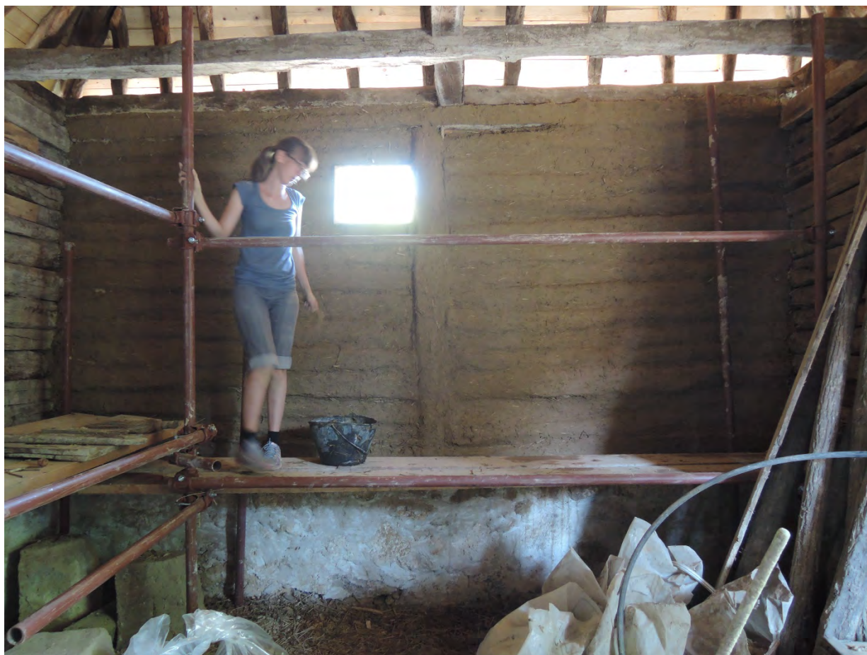
Завршен унутрашњи зид (један слој малтера)
