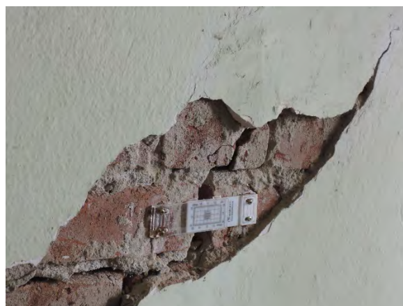
Обилазак куће Вучка Рајића, провера инструмената за мерење слегања конструкције и одабир столарије за радионицу
